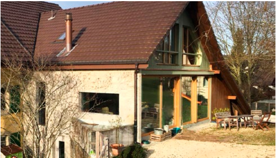
4.6 NACHHER: Öffnungen in der Seitenwand und die Verglasung der ehemaligen Toreinfahrt bringen Licht in den tiefen Innenraum, 25.01.2018
