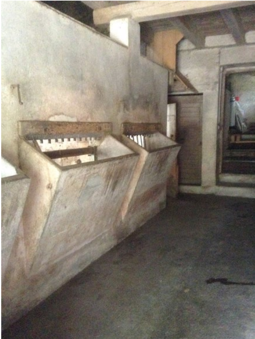
4.7 VORHER: Die betonierte Futtertröge, einfache Materialien und der überhohe Raum verweisen auf die ehemalige Nutzung, 29.06.2016
