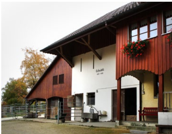
4.3 VORHER: Die Anlage «Hofmättli» mit Gehege, Stall, Scheune und Wohnhaus vor dem Umbau, 03.11.2015
