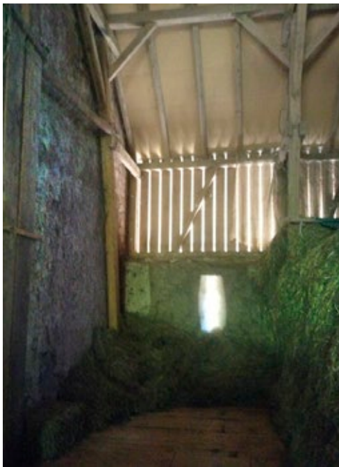
4.1 VORHER: Auf dem ersten Heuboden liegt noch das letzte Heu, das den Tieren verfüttert wurde, 29.06.2016
